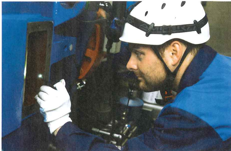
Ein Monteur kontrolliert per Videoskopie das Getriebe einer Windenergieanlage.
