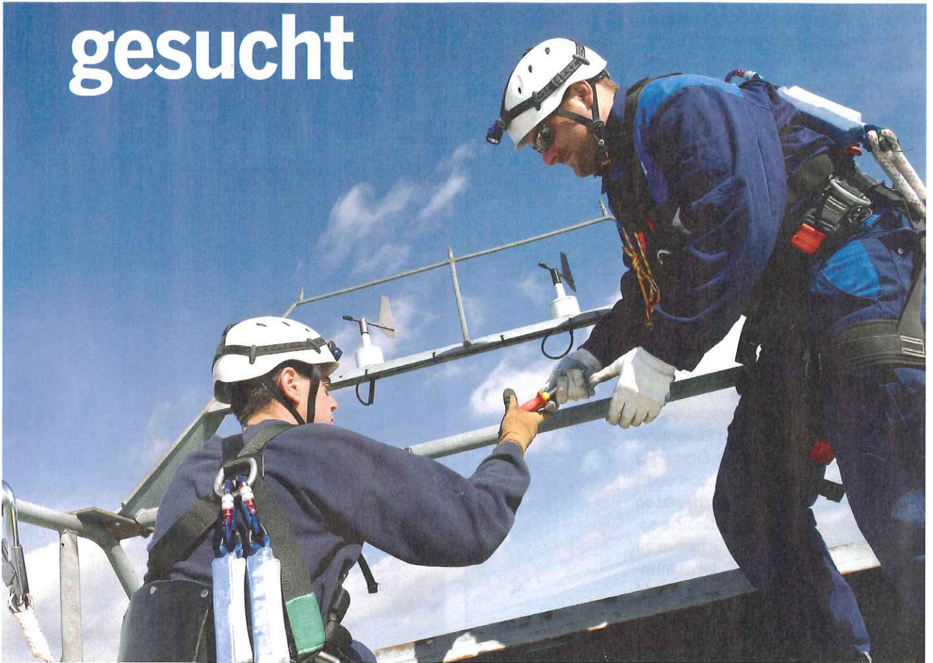
Zwei Monteure bei der Kontrolle der Windfahnen auf der Windenergieanlage
