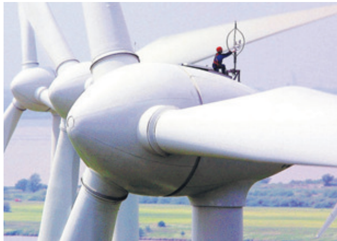
Nichts für schwache Nerven: Ein Windkrafttechniker justiert ein Windmessgerät auf einem Windkrafttrahler in 67 Metern Nabenhöhe.
